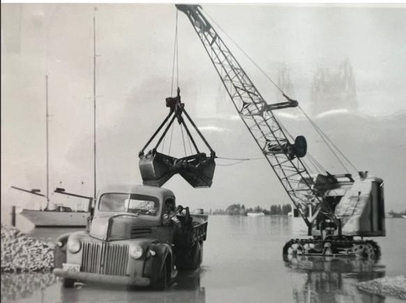
Hafen Staad | Aufnahme um 1958 | Die erste Maschine zur Schiffsentladung | Ein Seilbagger, was für ein Fortschritt!!! | Sogar bei Hochwasser konnten LKW's beladen werden
